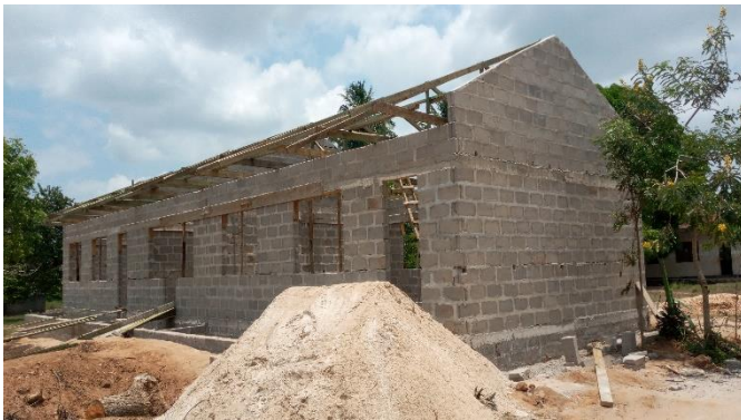
Ujenzi wa madarasa 02 ukiendelea.
