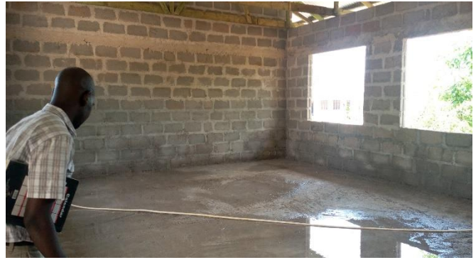
Muonekano wa ndani wa madarasa hayo 03.
