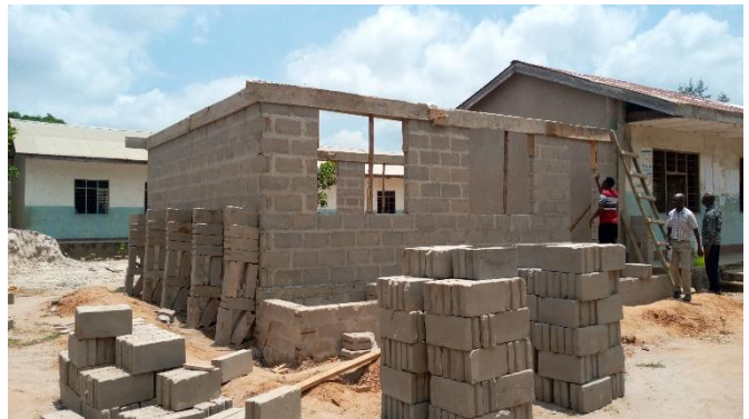
Ujenzi wa darasa 01 ukiendelea.
