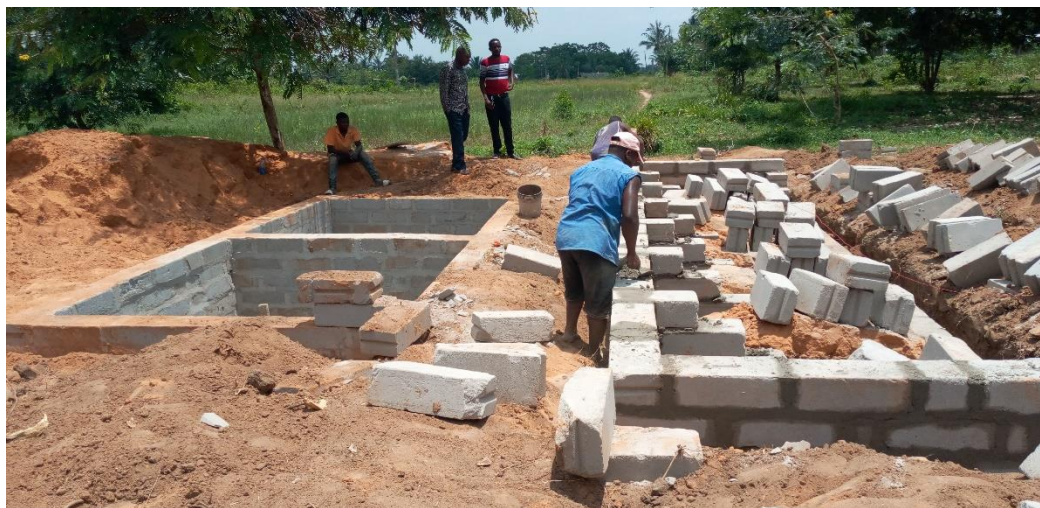
Ujenzi wa matundu 07 ya vyoo ukiendelea.
